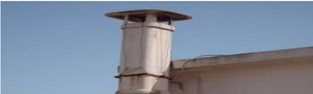
canne quadrangolari per camini, scarichi e spazzatura nei palazzi
